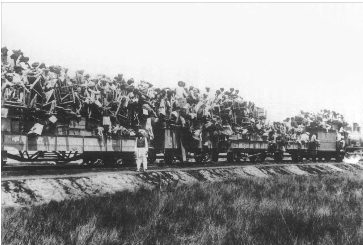
7.2. Équipe volante de poseurs de traverses pendant la construction du chemin de fer de l'Ouganda. [Photo: Royal Commonwealth Society.]
