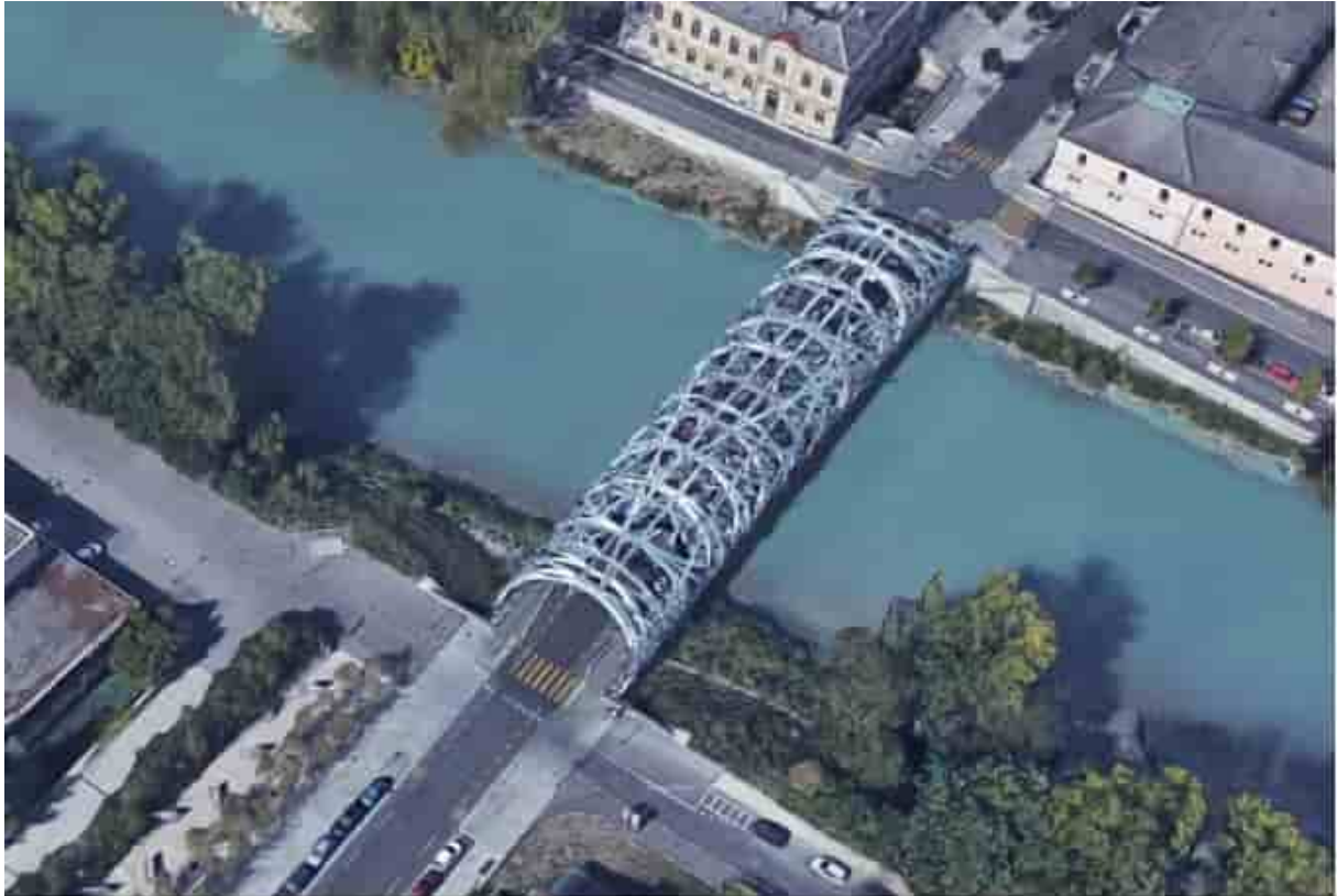
Vue aérienne du pont Hans-Wilsdorf
