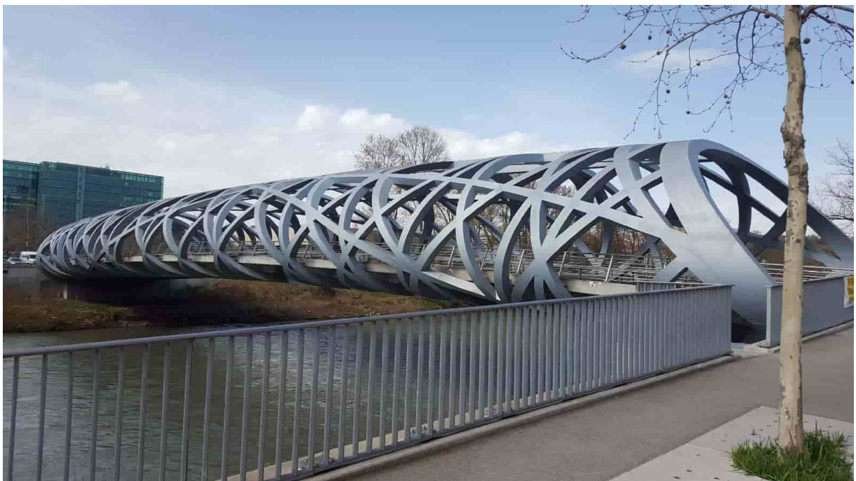
Pont vu de côté
