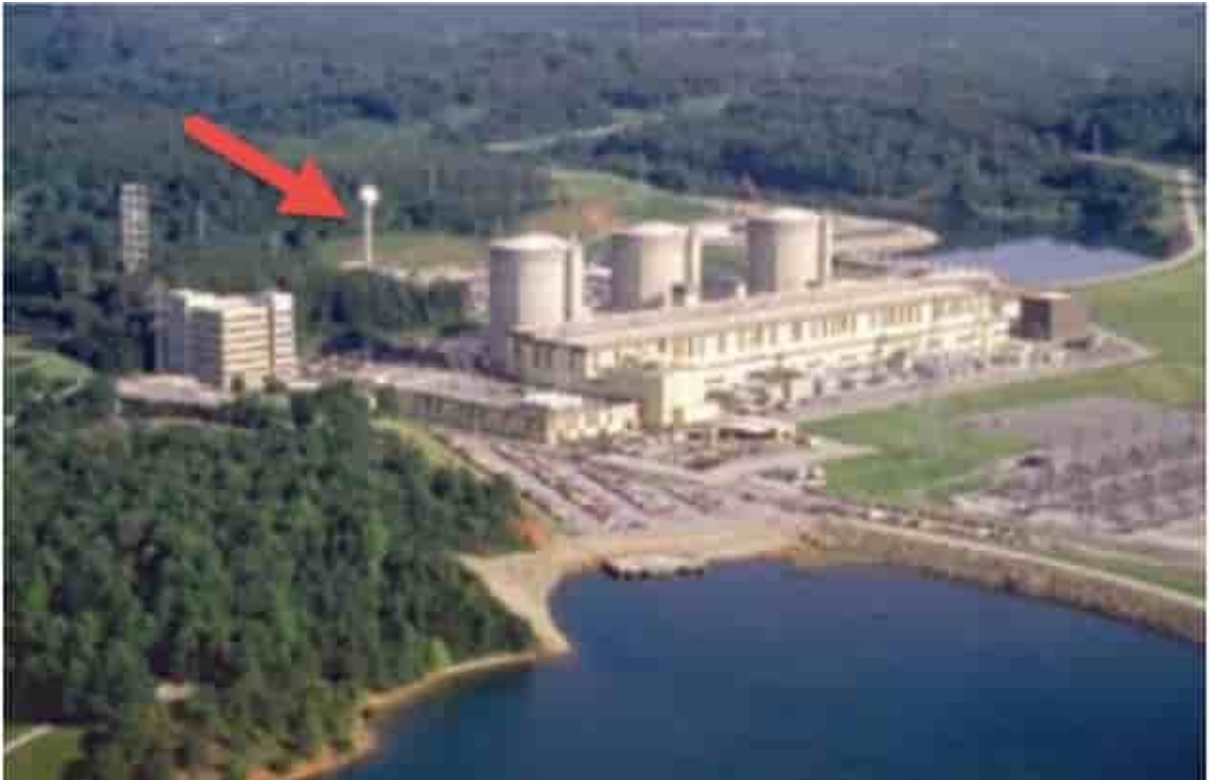
La cible : la centrale nucléaire de Oconee, la flèche désigne la tour de refroidissement
